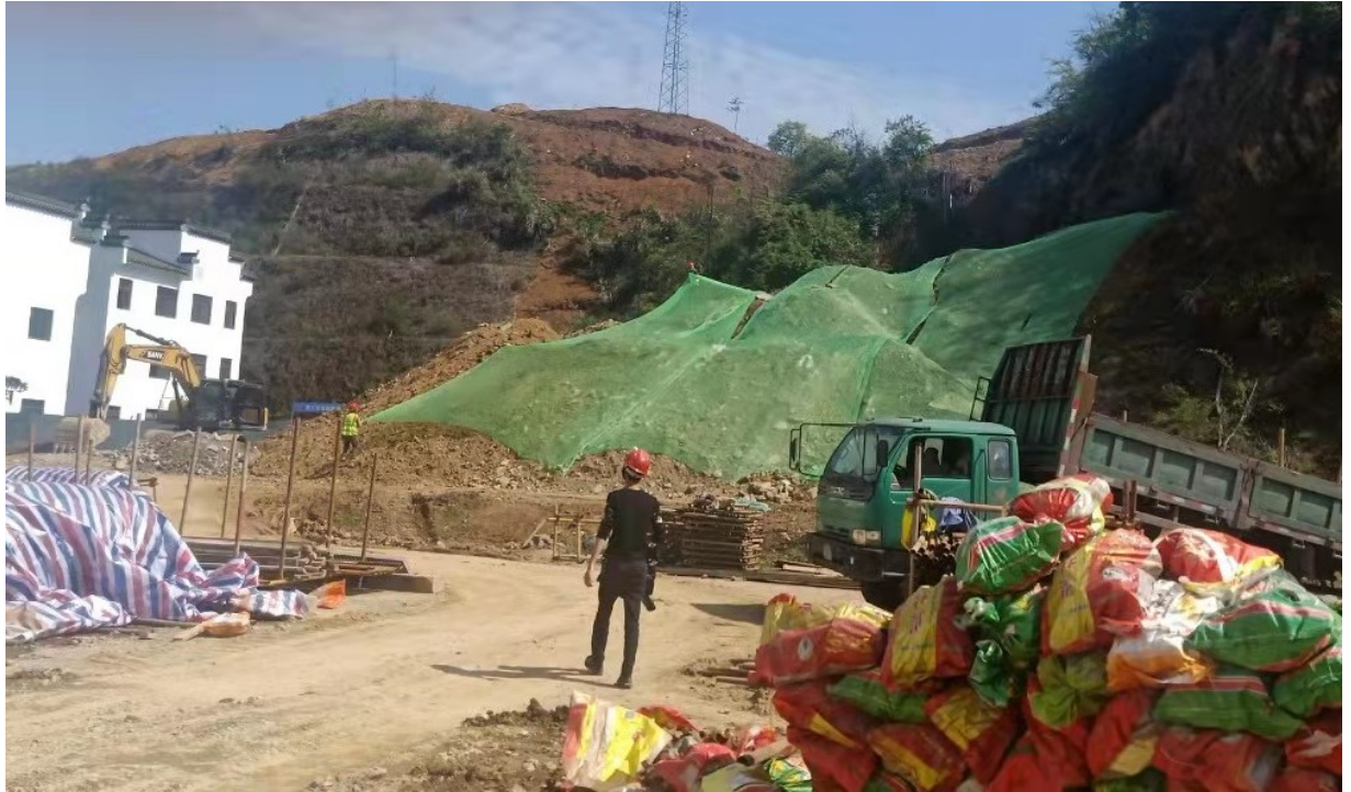
临时堆土区苫盖
