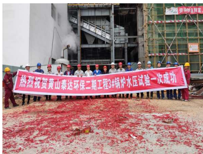
2021 年 10 月 27 日#3 锅炉水压试验
