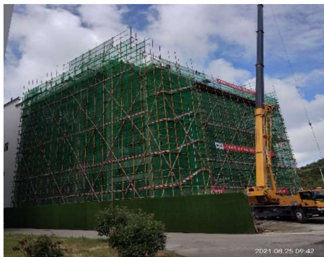
2021 年 08 月 30 日主厂房（汽机间）封顶
