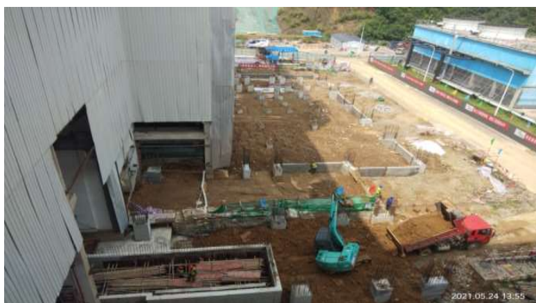
2021 年 01 月 29 日桩基工程施工完成
