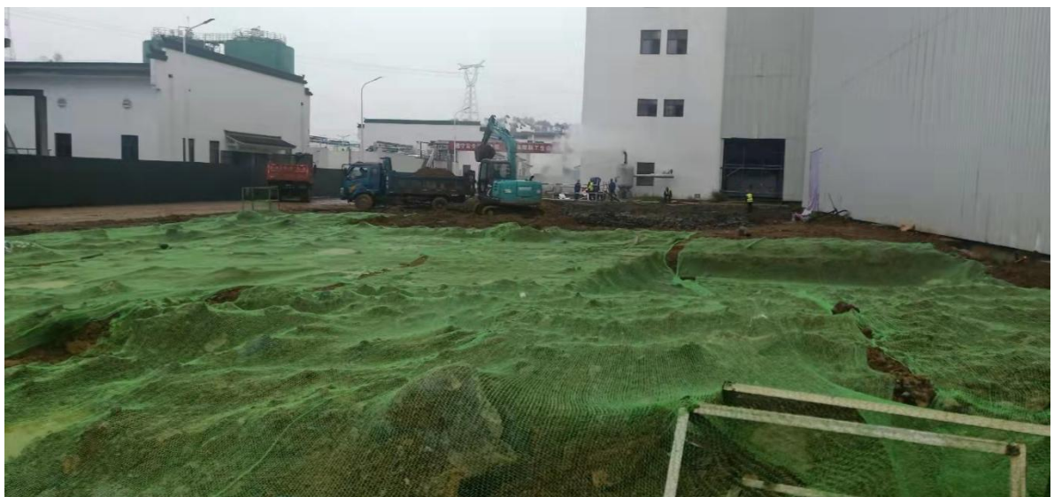
土地整理及地面苫盖
